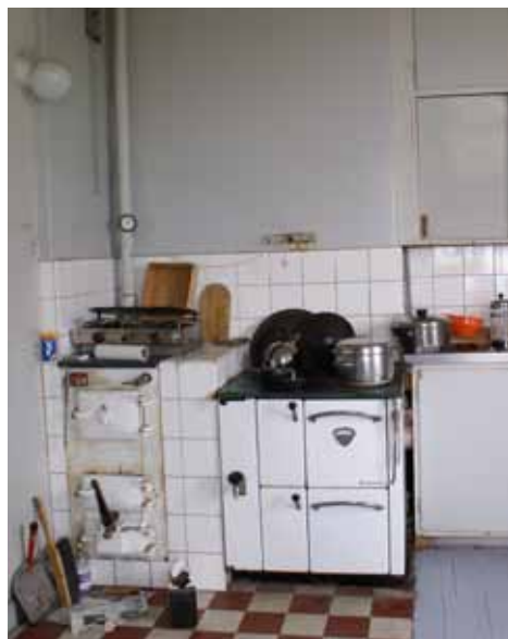
Det nya köket från 1944. Notera eldstaden för centralvärme.
